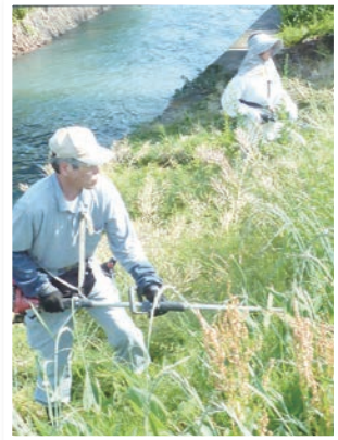
▲草刈機による除草作業
