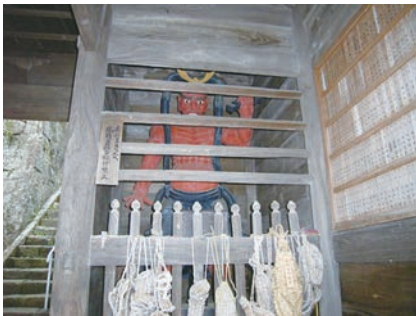
修復された仁王門
