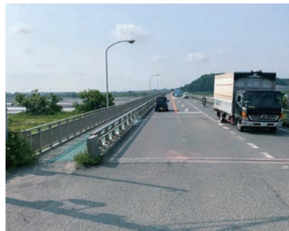
現在の新谷口橋
