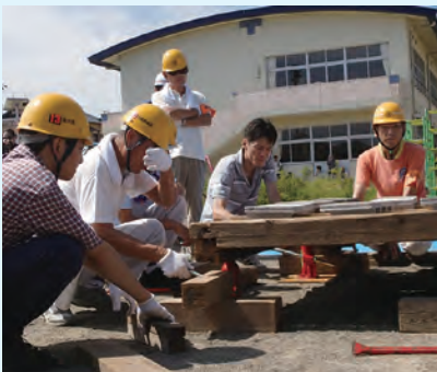
倒壊した建物からの救出は時間との闘い。チェンソーの操作に習熟している事が鍵
