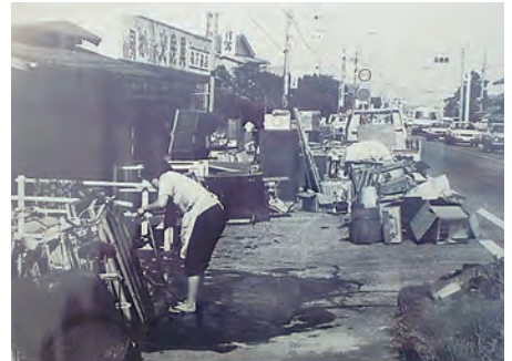
洪水による浸水の後片付け・岸町岸バス停付近
