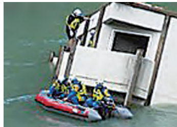
写真左：台風12号の被害の和歌山県那智勝浦町那智川の氾濫(9月4日朝)
